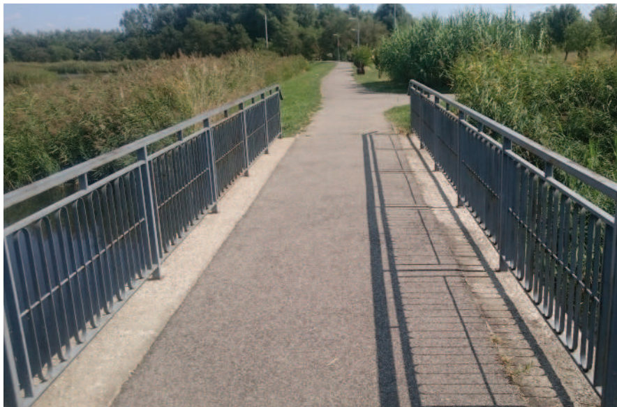
Híd a Polgári út melletti tónál.
