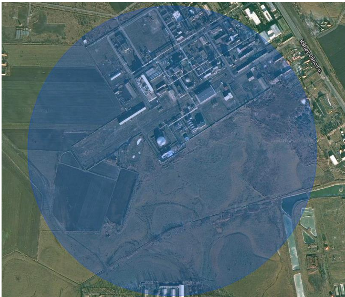
Mérgezés 1%-os halálozás indoor esetben (épületben belül tartózkodókra) Kimenekítési zóna 542 m
